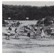
掛矢を用いた底固め
