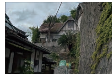
洋館、洋館付き住宅
